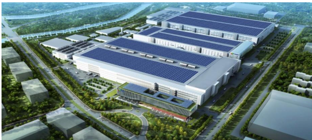
惠州厂区光伏发电项目
