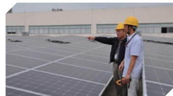
TCL 液晶产业园分布式光伏发电项目
